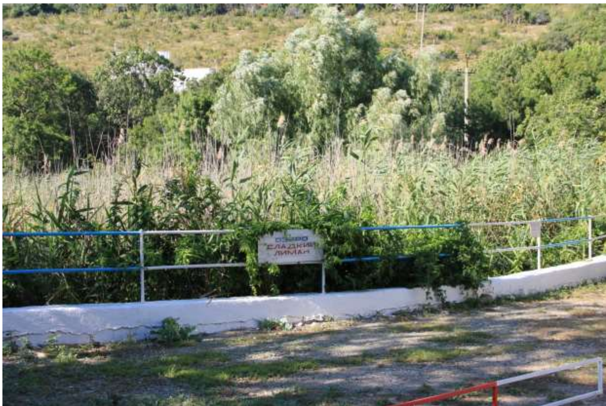
Рисунок 8.5 - Бетонное ограждение озера со стороны дороги на базе отдыха «Романтик»
