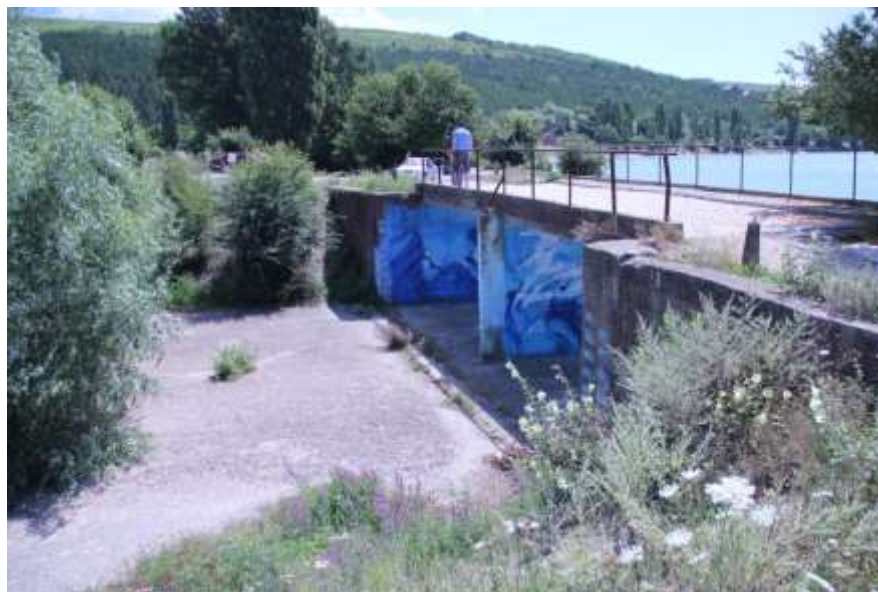
Рисунок 7.3- Верхний бьеф водовыпуска из отстойника в озеро
