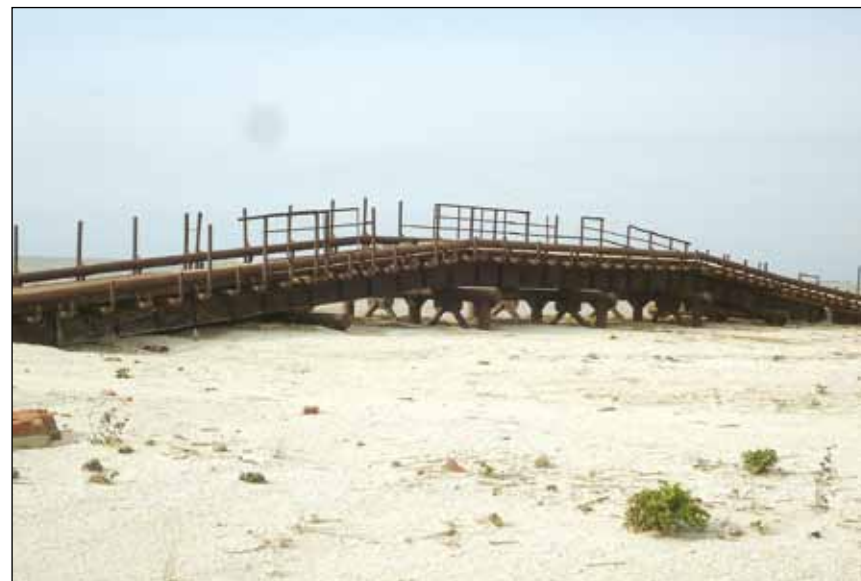
Мост через канал бывшего Бугазского гирла долгие годы был пляжной декорацией. Летом 2016 года его демонтировали
