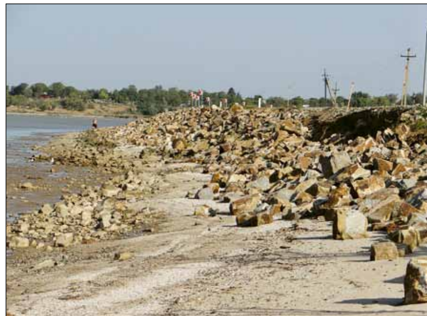
Дорога возле хутора Шиловка превратилась в глухую дамбу, препятствующую пропуску морской воды в Ханское озеро
